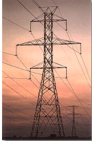
Aplicação estrutural do aço-carbono
